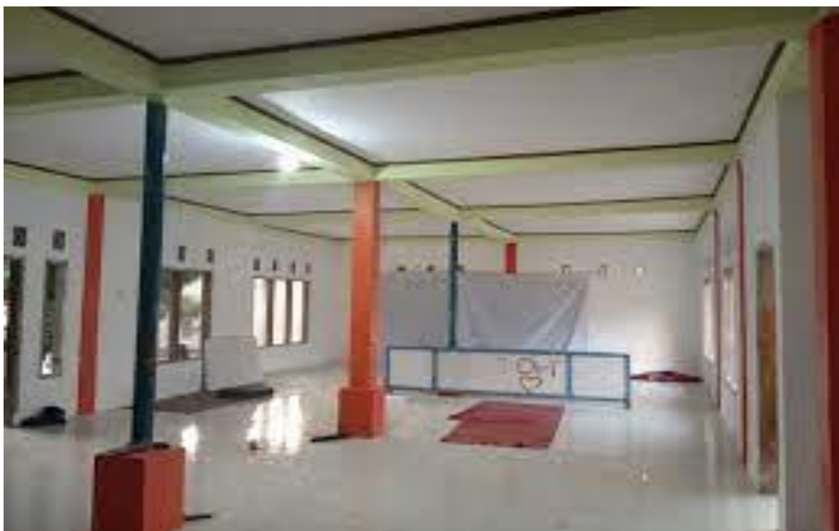
Dokumentasi Sesudah Pembangunan
